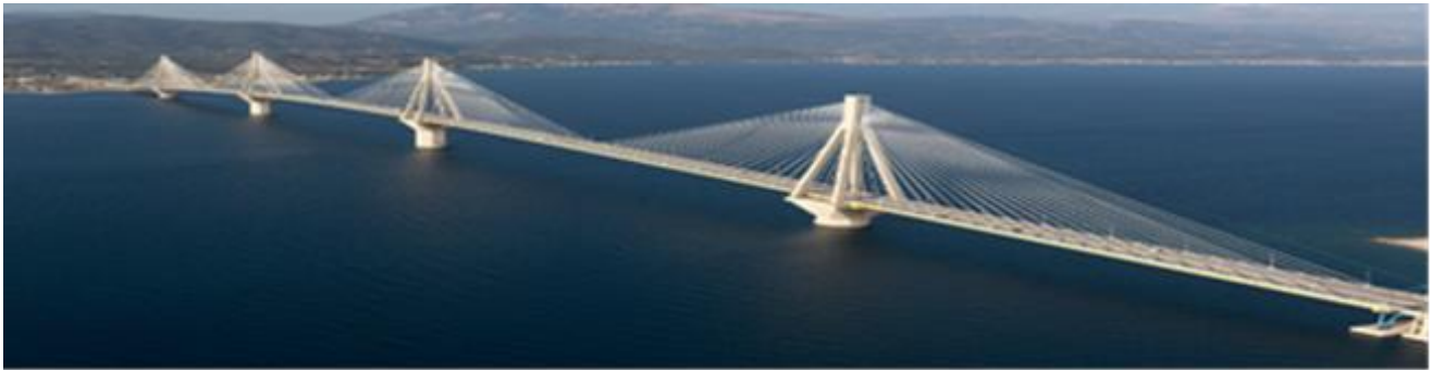
Fig. 9 Rio - Antirrio Bridge [28]
