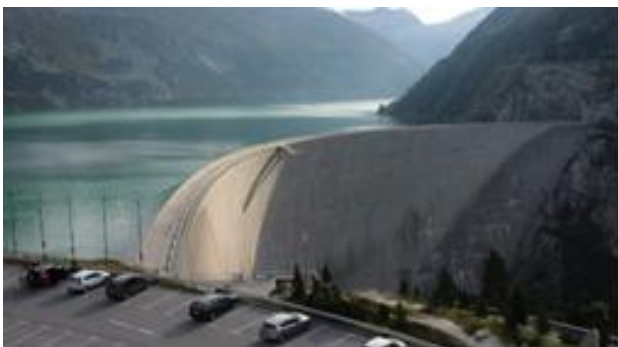
Figure 14. Kölnbrein Dam (Austria) [31]
