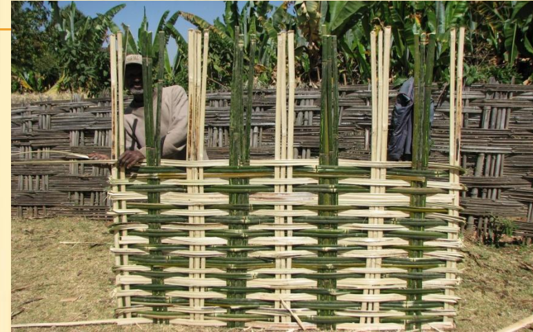
Κατασκευή πλεκτής περίφραξης από μπαμπού
