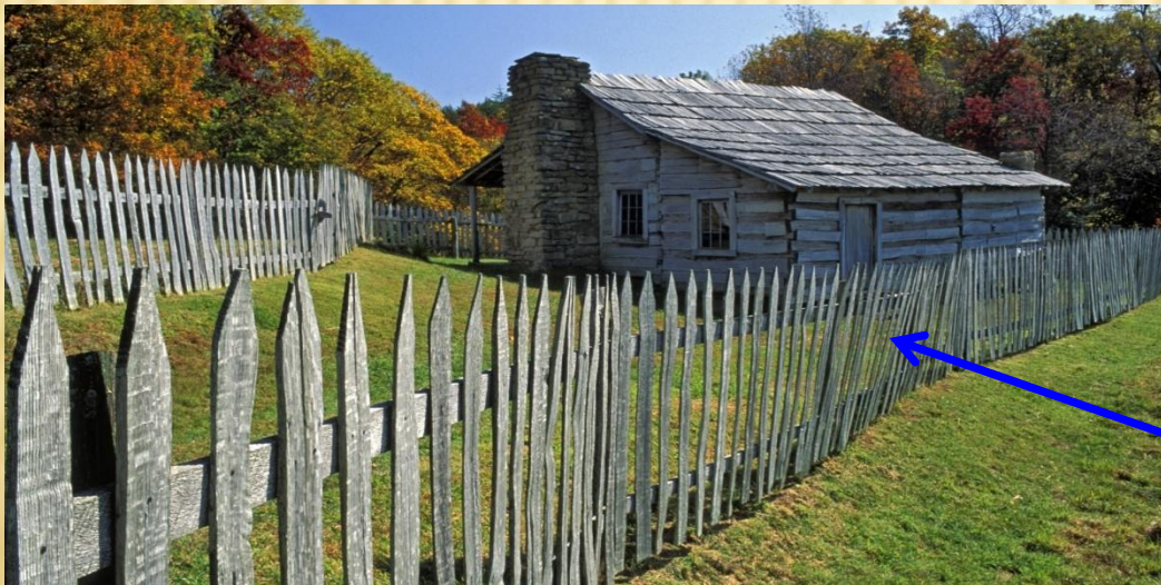
Σταθερός φράκτης οικίας από κατακόρυφες σανίδες
