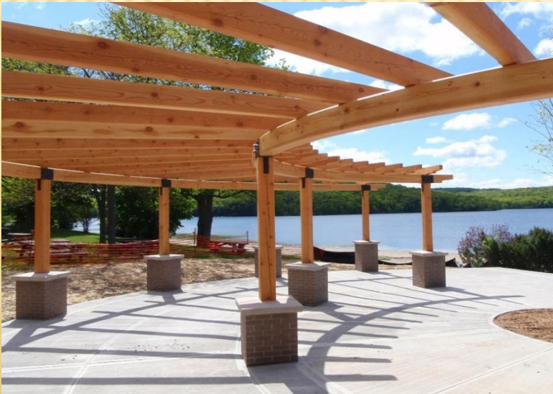
Κυκλική πέργκολα (πάκτωση σε μπετόν)
