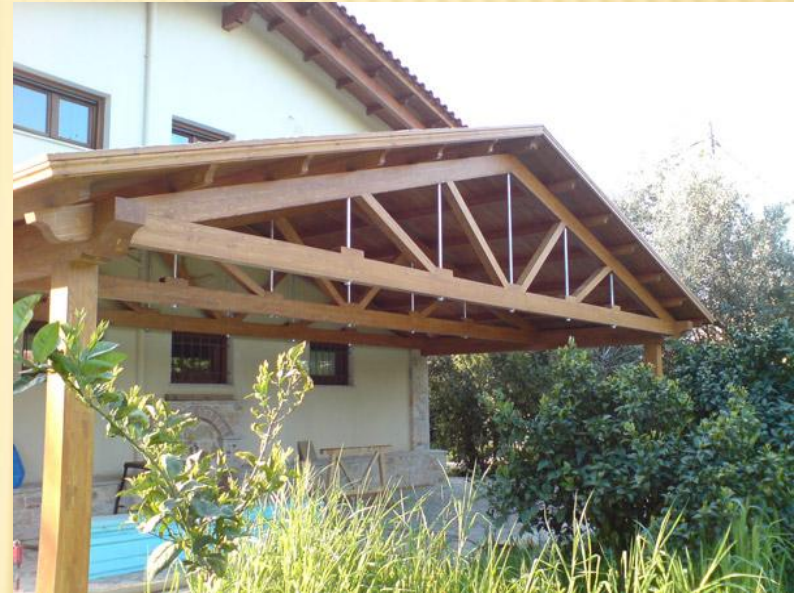
Υπόστεγο χωρίς ενδιάμεση κολώνα
