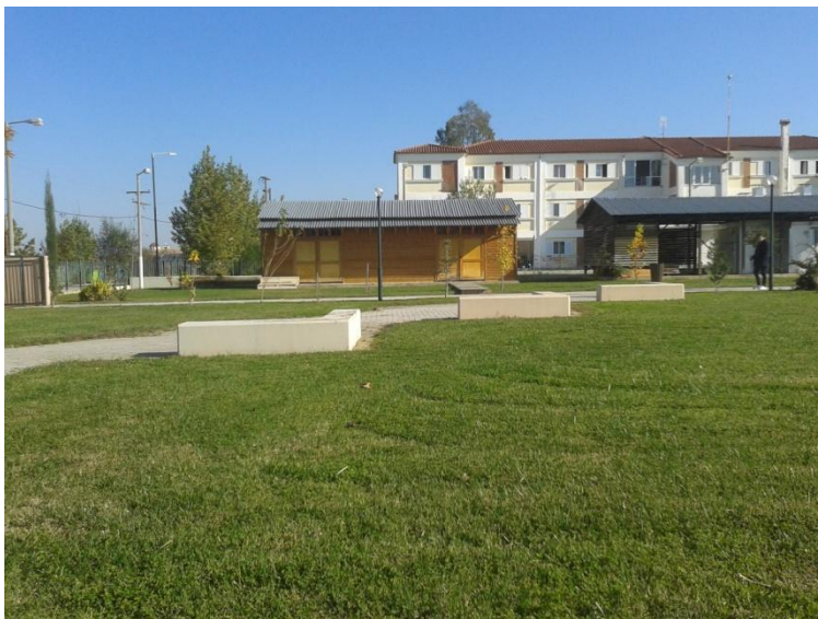
Εικόνα 13. Πλάγια δεξιά όψη χώρου τοποθέτησης πέργκολας.
