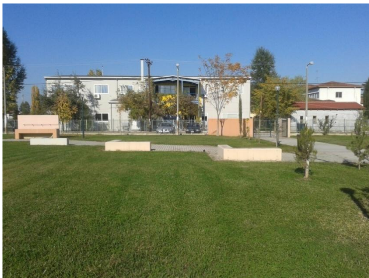
Εικόνα 15. Πίσω όψη χώρου τοποθέτησης πέργκολας.
