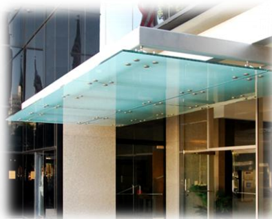
Εικόνα 5 Σύστημα "αραχνοειδούς" τοποθέτησης στεγαστρου από γυαλί σε είσοδο
