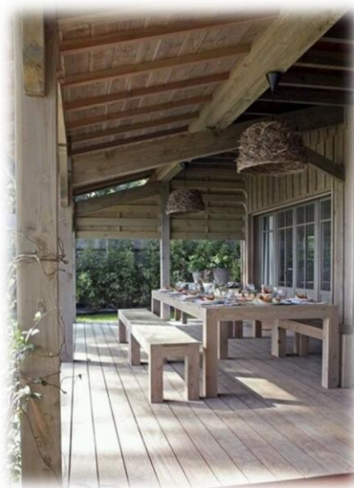
Ξύλινο σκέπαστρο βεράντας, από εμποτισμένη ξυλεία πεύκου
