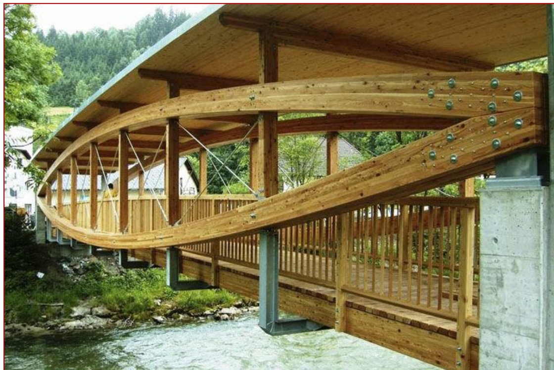
Εικ. 1. Ξύλινη πεζογέφυρα από καινοτομικό υλικό ξύλου, συνδυασμένη με σκέπαστρο για προστασία όλης της κατασκευής από τον καιρό και την υγρασία.
