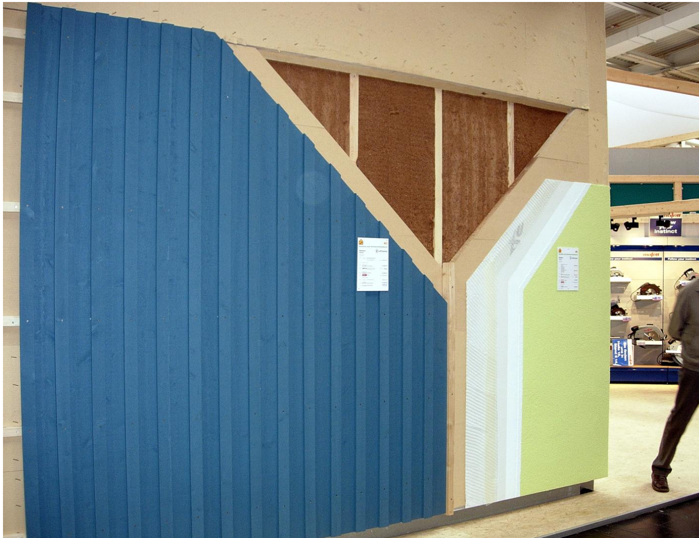
ΕΙΚ. 2. Κατακόρυφη τοποθέτηση σε ξυλεπένδυση
