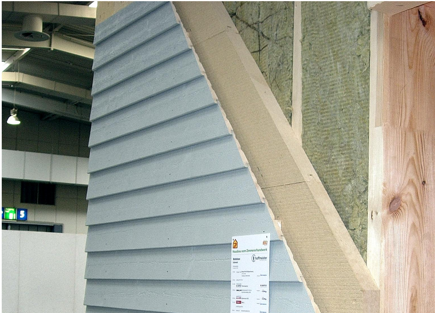
ΕΙΚ. 3. Οριζόντια τοποθέτηση σε ξυλεπένδυση
