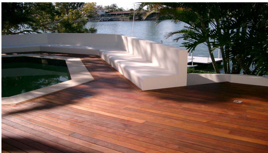
Δάπεδο εξωτερικού χώρου (decking) από τροπική ξυλεία Merbau.
