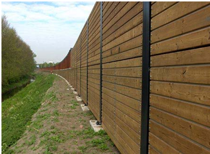
Ξύλινη κατασκευή σε ηχοπέτασμα
