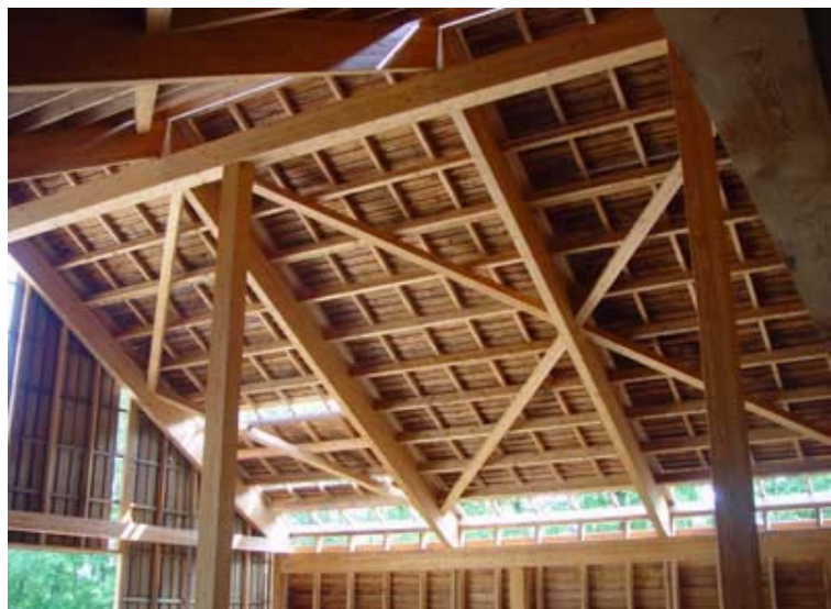
Ξύλινη κατασκευή σε στέγη
