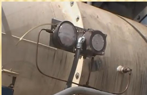
ΑΝΙΧΝΕΥΤΗΣ ΦΩΤΙΑΣ & ΠΥΡΟΣΒΕΣΗ (SPARK DETECTOR & FIRE EXTINGUISHER)
