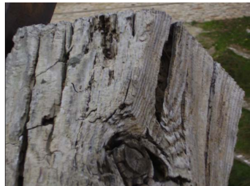
Εικ. 1. Μονές Μετεώρων: οι κατασκευές ξύλου υφίστανται γήρανση από τη συντονισμένη επίδραση των εξωτερικών παραγόντων.
