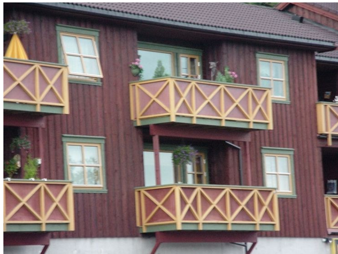
Εικόνα 18: Ξυλοκατασκευή με εξωτερική επένδυση τοίχων από WTT
