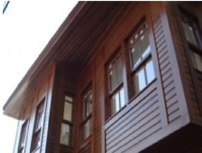
Εικόνα 4: Εξωτερική επένδυση τοίχου από ThermoWood .
