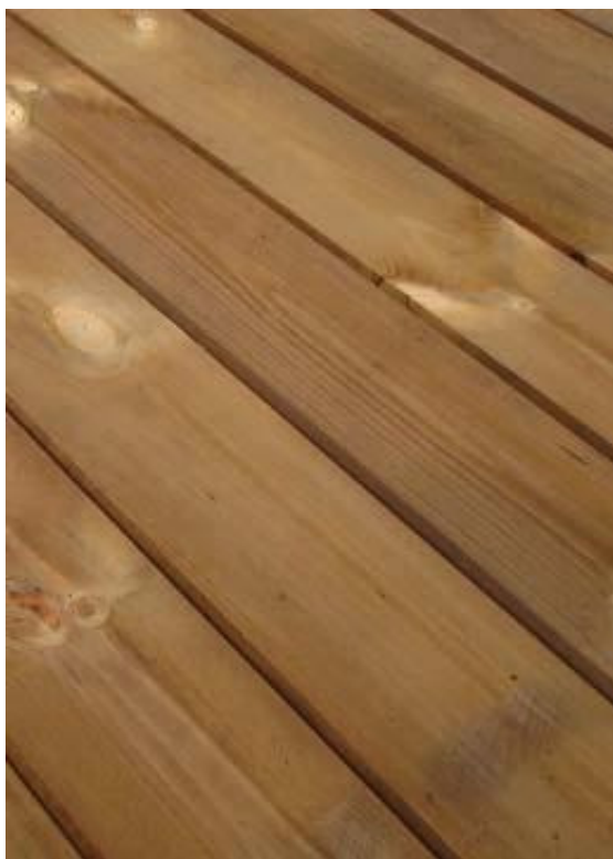
Εικόνα 13: Κατασκευή εξωτερικού πατώματος από VisorWood
