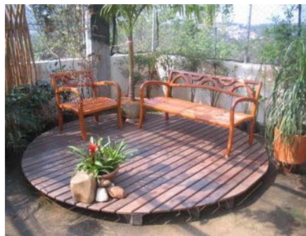
Εικόνα 27. Εξωτερική κατασκευή από ξύλο Tatajuba
