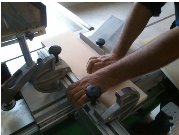
Εικόνα 18.1: Κατεργασία τεμαχίου στη γωνιάστρα.
