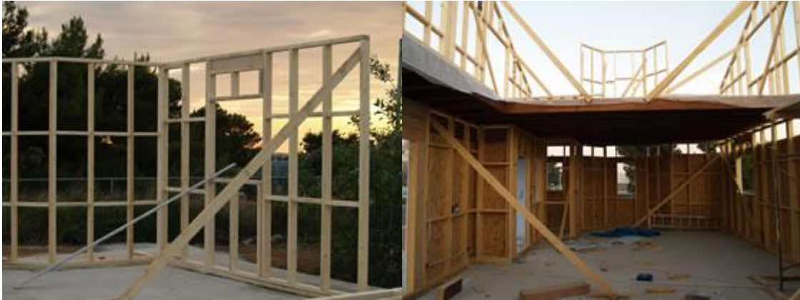
Εικ. 2.7. Σκελετός και τοιχοποιία ξύλινου σπιτιού.
