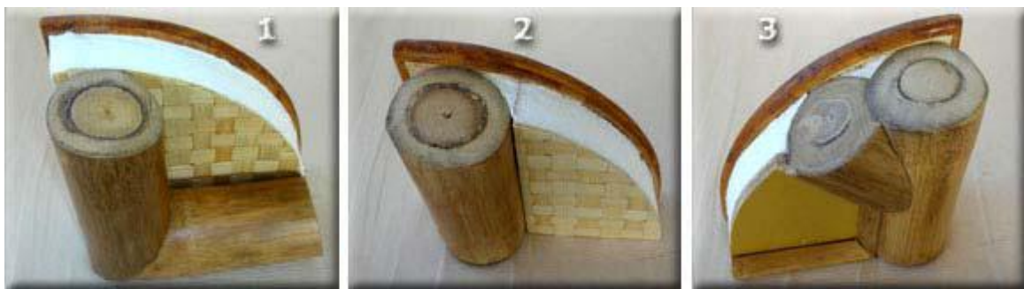
Εικ. 2.24. Τοιχοποιία κατοικίας από μπαμπού α) το πάνελ τοιχοποιίας 3 στρώσεων στερεώνεται έξω από τους ορθοστάτες μπαμπού, β) οι ορθοστάτες εσωκλείονται στο πάνελ τοιχοποιίας.
