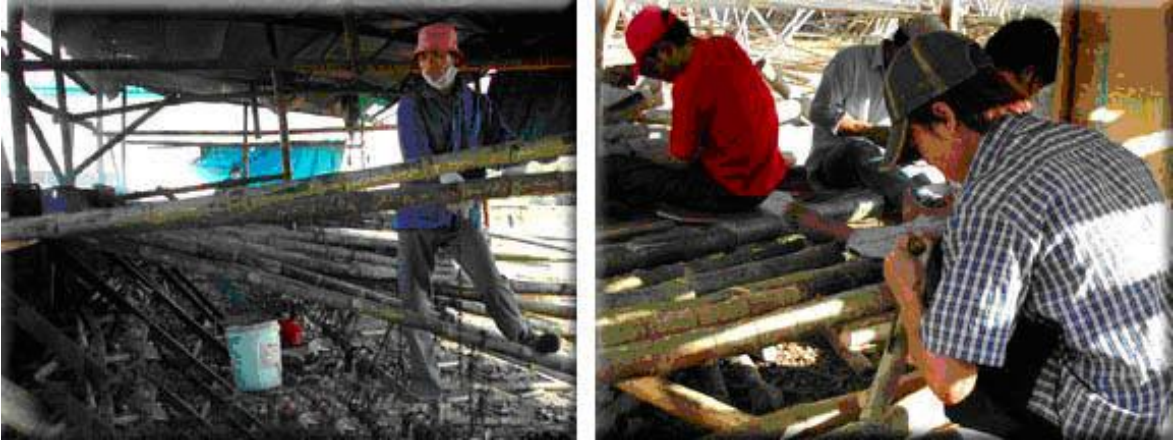
Εικ. 2.21. α) Ταξινόμηση και καθαρισμός των κορμιδίων (στύλων) μπαμπού.
