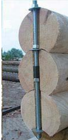
Εικ. 2.5. Σύνδεση με ανοξείδωτες μεταλλικές ράβδους.
