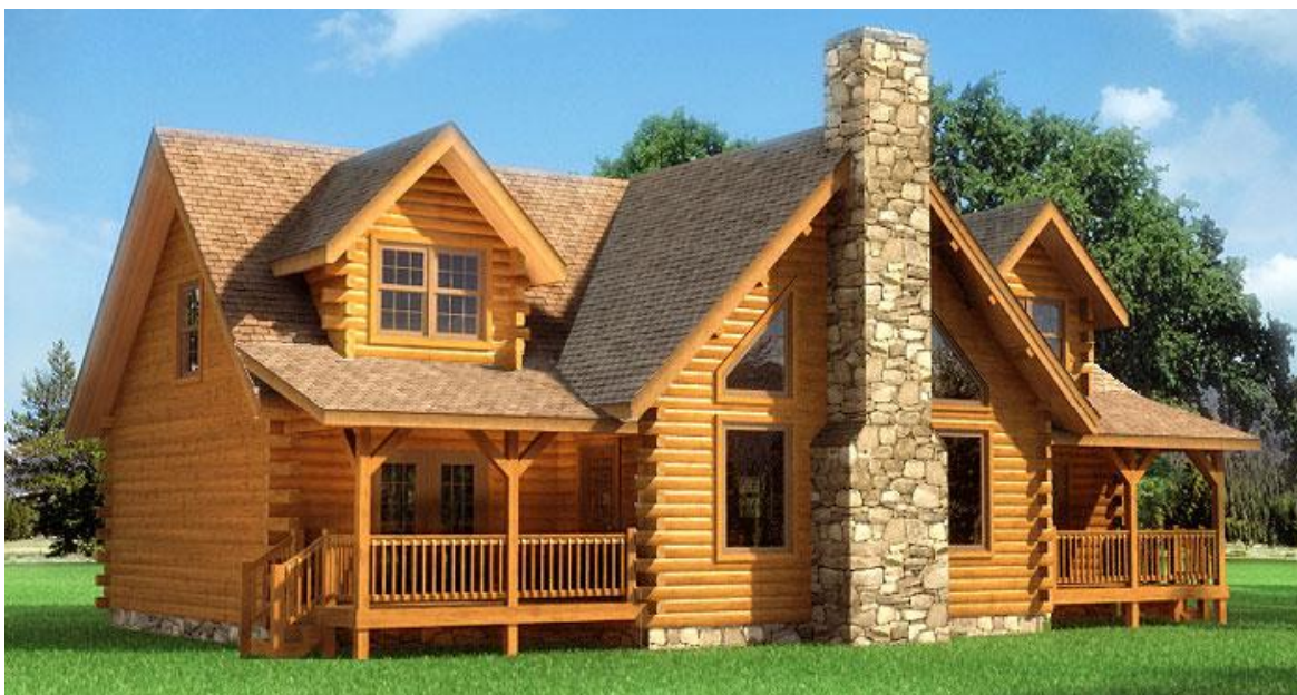
Εικ. 2.3. Κατοικία με οριζόντια τοποθέτηση κορμών.
