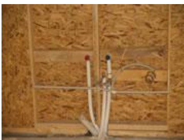
Εικ. 2.10. υδραυλική εγκατάσταση.
