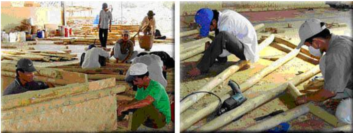
Εικ. 2.20. Κατασκευή των πάνελ.
