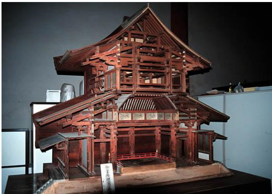
Εικ. 4.4 Μακέτα του ναού που δείχνει την κατασκευή του ξύλινου σκελετού.
