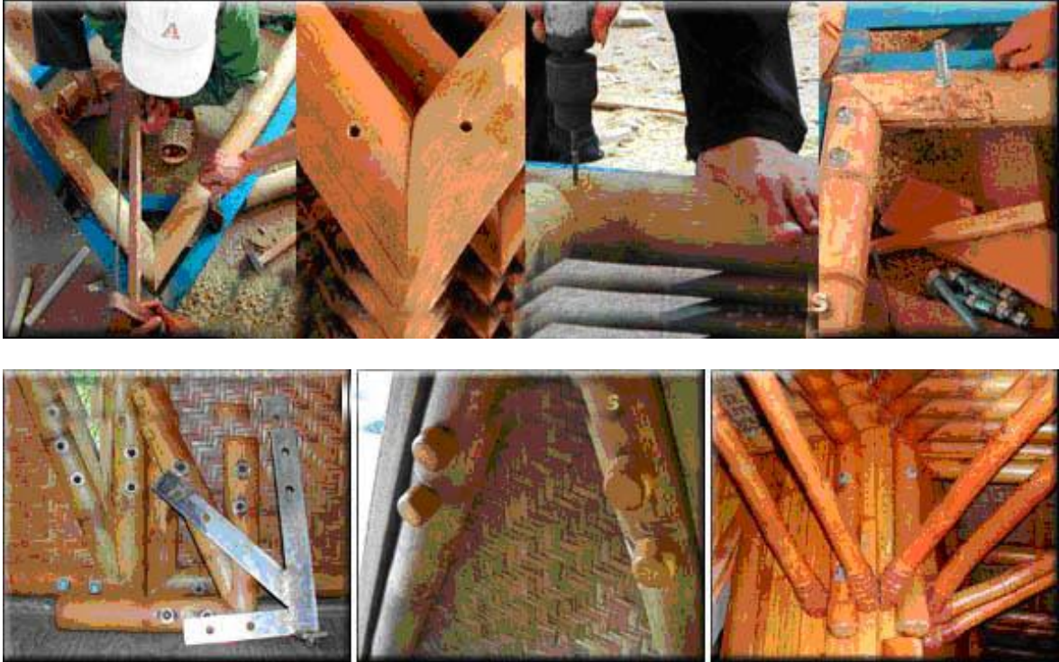
Εικ. 2.22. Συνδέσεις με ενισχυμένες χαλύβδινες πλάκες και μπουλόνια.
