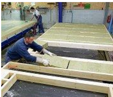
Εικ. 2.16. Κατασκευή πάνελ.
