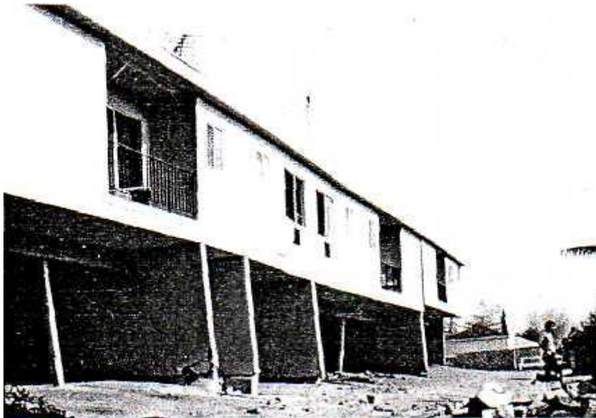
Εικ. 4.2. Κατοικία με σοβαρή ατέλεια αδύνατης κατασκευής ισογείου (San Fernando Earthquake, 1971)
