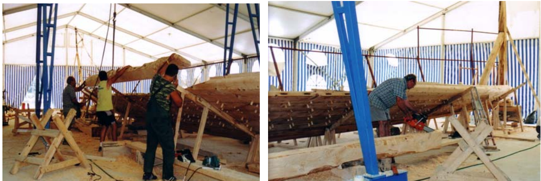
Εικ. 8.34 Κατασκευή της Αργούς.
