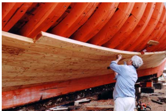
Εικ. 8.12 Κάρφωμα του πετσώματος στο εμπορικό ιστιοφόρο σκάφος «ΚΙΡΚΗ».
